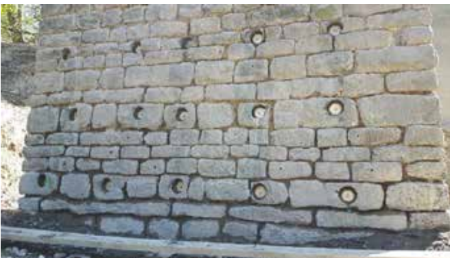
Verankerung im Pfeilerbereich (Unterbau)
