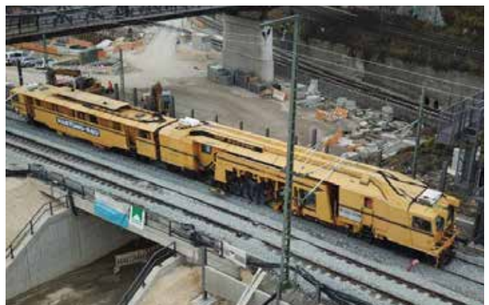
Stopfmaschine Gleis 402 – Stopfvorgang
