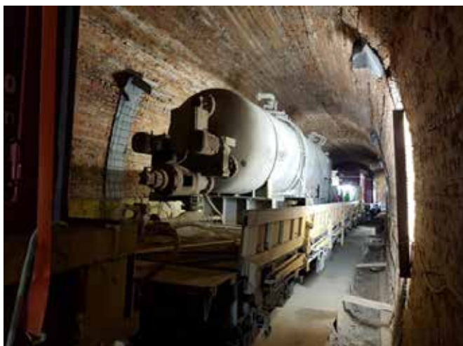
Spritzbetonarbeiten Kalmut
